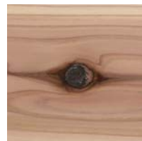
パテ・埋め木処理
