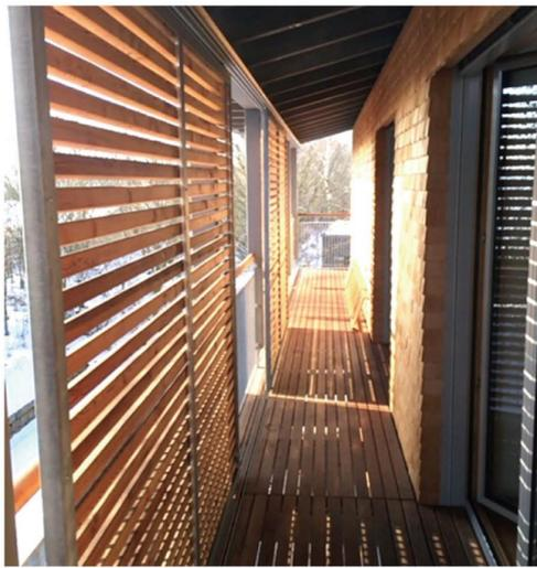
平行四辺形などのサイディングは、外付けスライディング日射遮蔽にも活用できます。性能だけでなく、デザインや素材感で圧倒的な差別化ができます。
