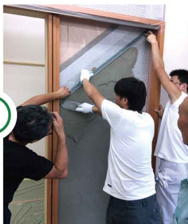
▲ APMの断面を確認できる仕上げ施工中です
