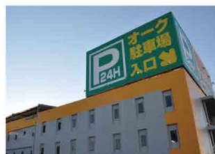
▲ 熊谷駅南口 立体駐車場
