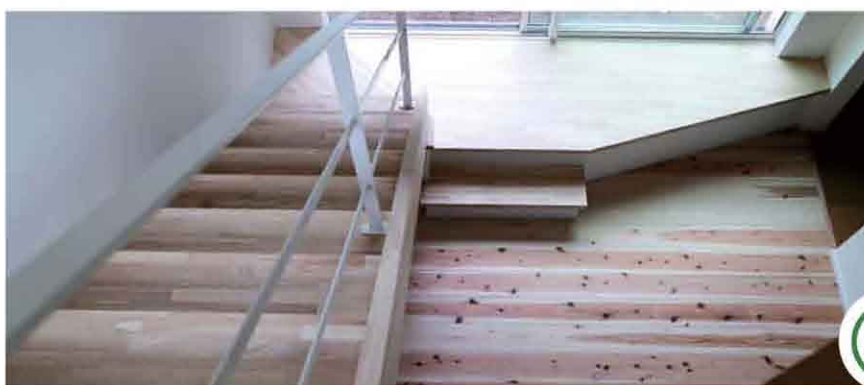
▲ 階段：レッドパイン三層板 ラバーウッド
