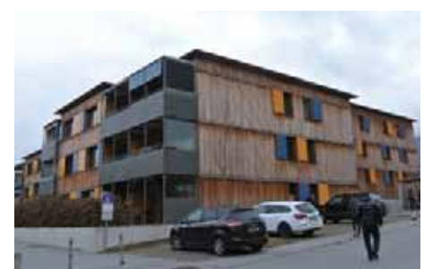
▲パッシブハウス集合住宅
