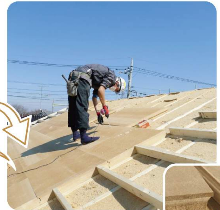
▲ プラスを施工
