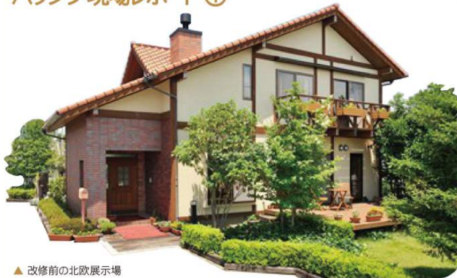
▲ 改修前の北欧展示場
