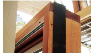
▲膨張気密テープ施工
