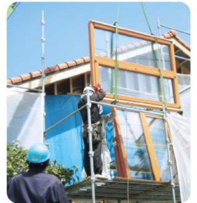
▲膨張気密テープ施工
