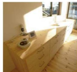
▲長さ4.5mの大型キャビネット 天板は三層板1枚で製作 扉も全て三層板
