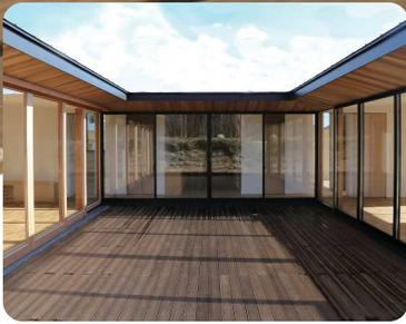
北欧フィンランドで生まれた高温乾燥技術「サーモ処理」。その歴史を紐解けば、「バイキング」の時代まで遡ることができます。バイキングたちの使用する船は、激しい航海・海水に耐えうる屈強なものではなくてはいけません。そこでバイキングたちは火を使って木の耐久性を高め、船に使っていました。昔から使われていたその「高温乾燥」のアイデアを現代に蘇らせたのがサーモウッド。製造工程はコンピュータ制御され、215℃もの高温で乾燥させることで、高品質のサーモ処理が実現しました。
